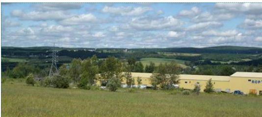
Parc industriel et ligne hydroélectrique
